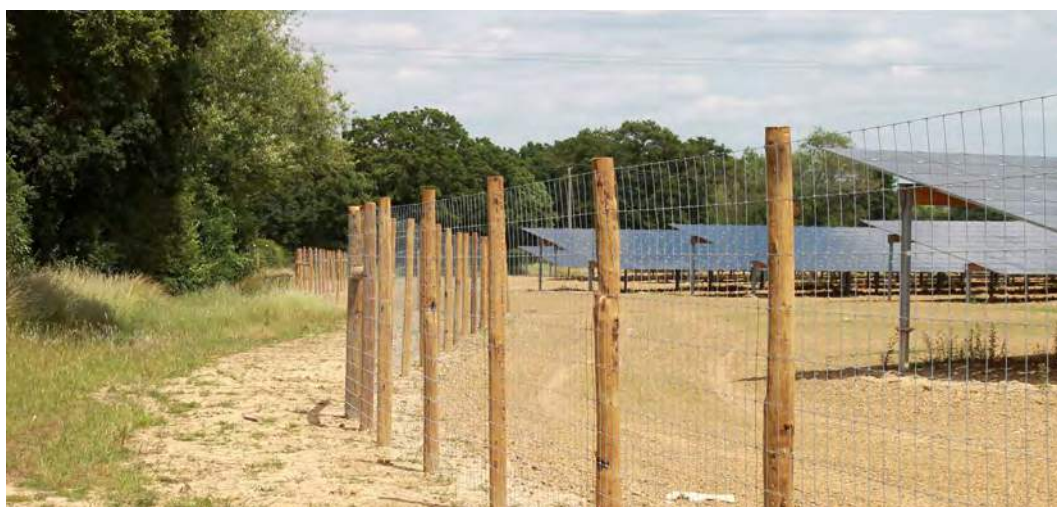
Afbeelding 21. Referentie hekwerk: houten palen en schapengaas (voorkeursvariant)
